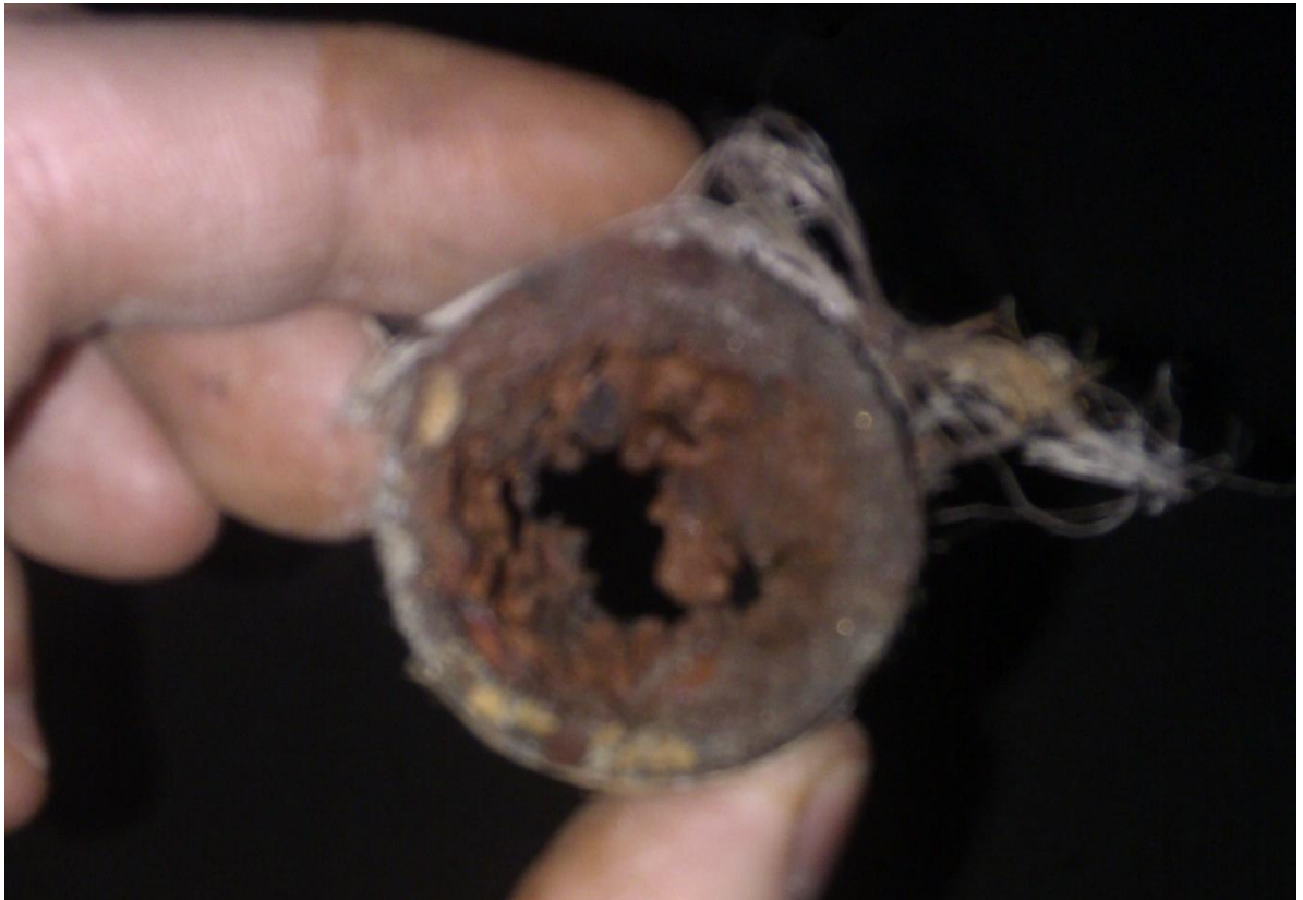
Фото. Район Уктус. Трубопровод горячего водоснабжения.
