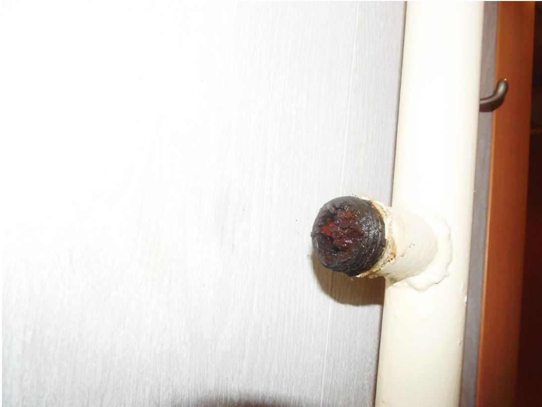
Фото. Район Краснолесье. Трубопровод горячего водоснабжения.
